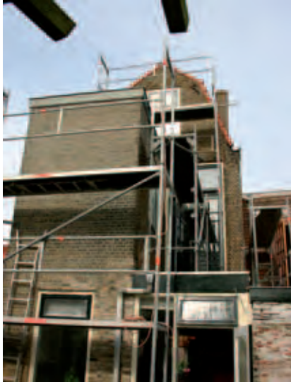
Figuur 1a: Het vervangen van voegwerk; een voorbeeld van gewoon onderhoud
